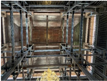
Gambar 6. Rangka Kayu Bangunan Masjid Agung Sang Cipta Rasa
