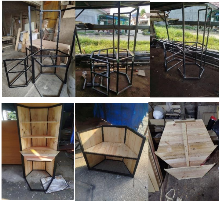
Gambar 11. Kerangka Besi dan Kayu palet bekas yang sudah dibentuk dan dipasang. Sumber: Azkany, 2026
