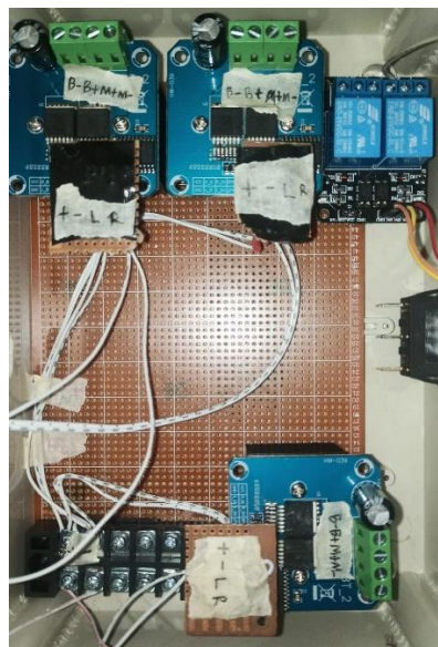
Gambar 8. Proses Wiring ESP32 bagian Output
