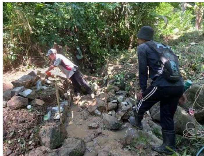
Gambar 7. Pembuatan saluran air / embung
