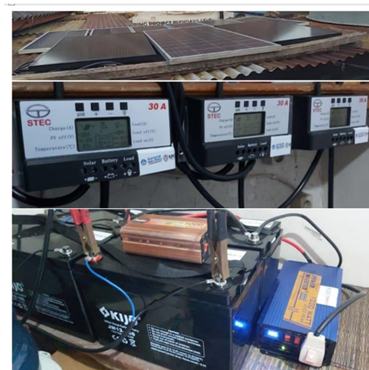
Gambar 5. Sistem Panel Surya Terpasang Baru
