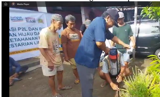
7c. Praktek pembuatan lubang biopori
