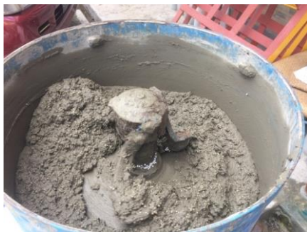
Gambar. 1. Proses pencampuran beton busa
