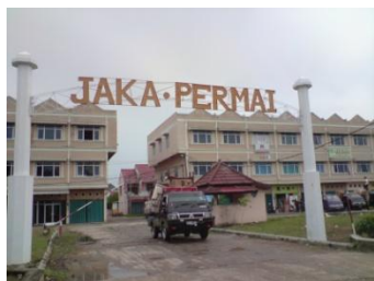
Gambar 3. Gerbang Komplek Perumahan Jaka Permai (sumber: survei peneliti, 2010)
