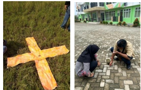
Gambar 4. Pemasangan Titik Kontrol dan Pemasangan Premark Titik Kontrol
