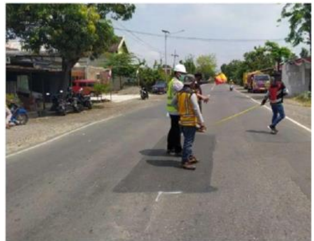
Gambar 3. Pengambilan kerusakan Jalan
