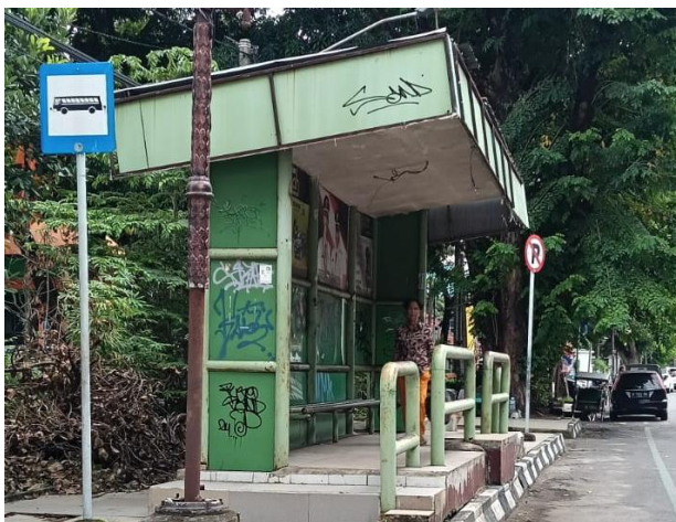
Gambar 17. Halte Pedestrian Jalan Merdeka
