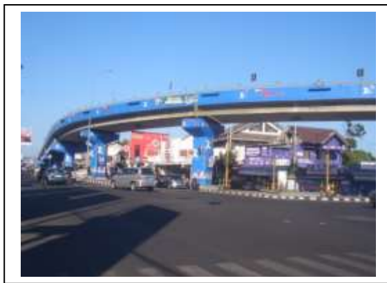
Gambar 23. Jembatan Layang Janti Sumber : dokumen pribadi
