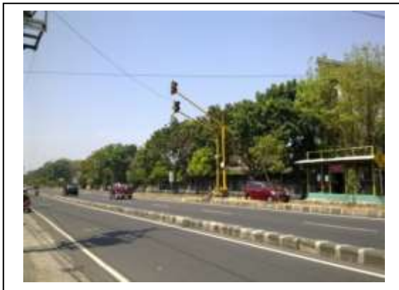
Gambar 18. Jalan Ringroad Utara Sumber : dokumen pribadi
